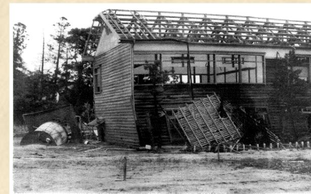
当時の根岸中学校では、液状化により校舎が傾斜し壁が落ち、簡易水道タンクは地中に埋没してしまいました。(根岸地区住民撮影)
