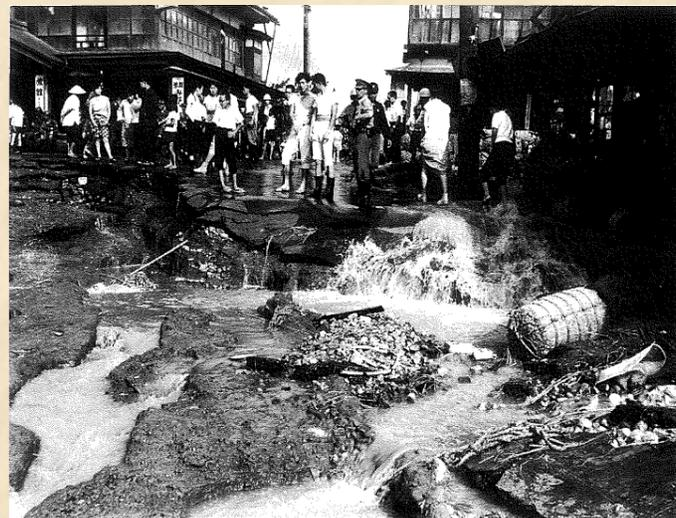
集中豪雨で中之口川が増水し、旧富月橋付近から水が堤防を超え町に向かって猛烈な勢いで流れ込みました。土のうや石俵で防ごうとしましたが押し流されるばかりで、やむなく政府米を土のうの代わりに使う決断をし(米俵事件)、被害の拡大を防ぎました。
